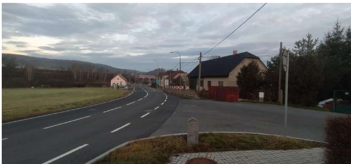
Obrázek 1: Křižovatka silnice II/605 x III/11710, dopravní sonda, prosinec 2024
