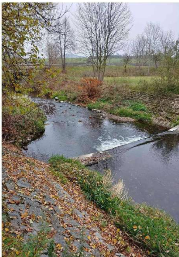
Plocha 5 - rozvolněný břehový porost podél upraveného koryta
