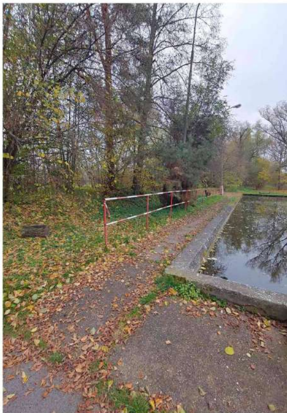
Plocha 3 - betonová nádrž u potoka na okraji hřiště
